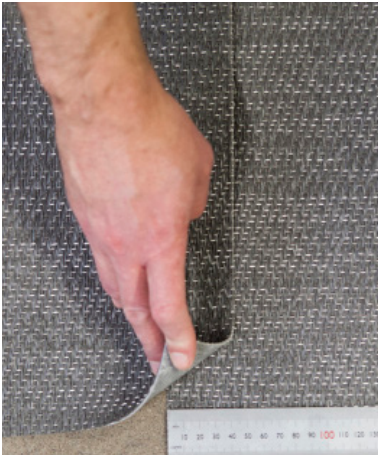
BOTANIC 1.4 cm Überlappung von 2 Bodenfliesen und Doppelschnitt.
