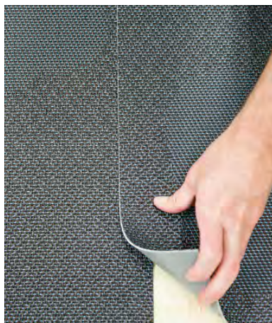
点 1. 两块板材有 4 cm 的重叠部分，双切。 确保不要在大圆里切割。
