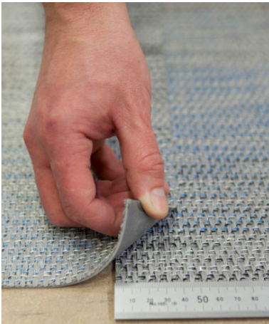
FLOW 1. 4 cm Überlappung von 2 Bodenfliesen und Doppelschnitt.
