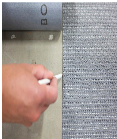
3. Rulla/vik över första våden och markera skarvens position på undergolvet.
