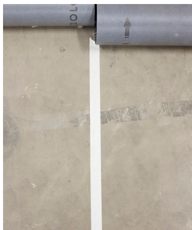
4. Rulla/vik över angränsande våd och maskeringstejpa skarvens position.
